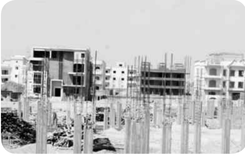
استثمارات في قطاع المباني
